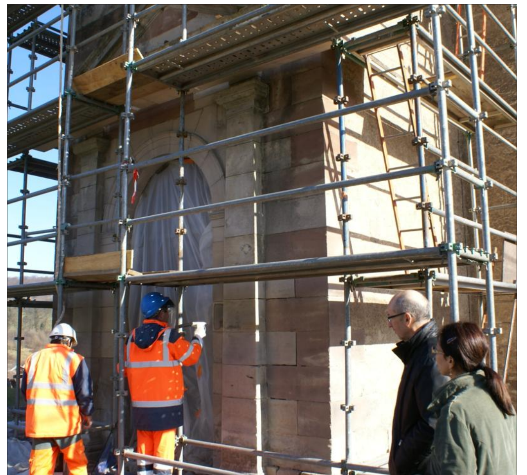
■ Thomas Kuehm, professionnel encadrant, et Damien Laurençot à l'opération d'aérogommage de la façade principale du temple.
